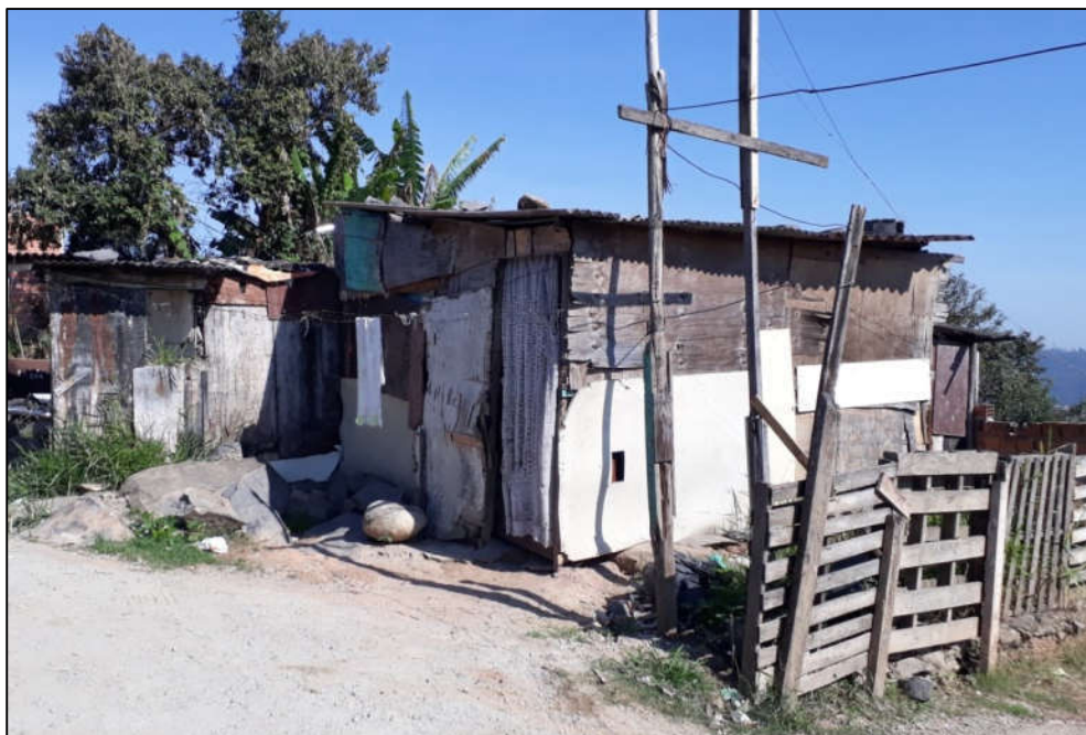
Foto FC-ITA-07-03.03: Moradias de madeira situados no setor.
