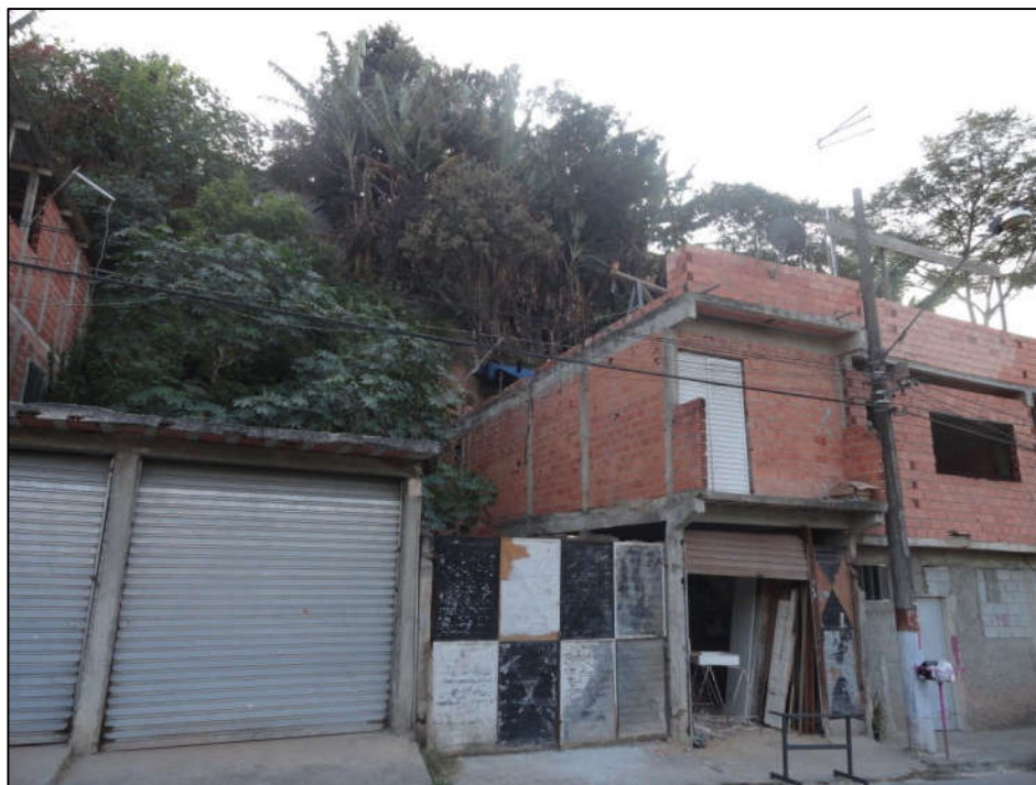
Foto FC-ITA-05-04.01: Vista das moradias em frente à Rua Japi e o talude do setor.
