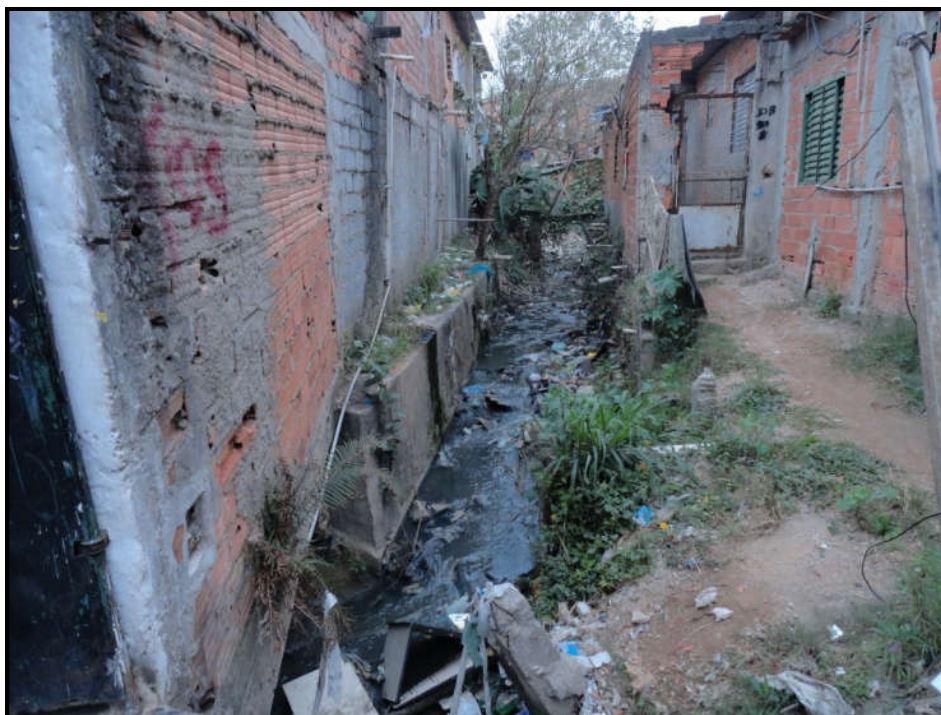
Foto FC-ITA-06-03.01: Vista do córrego em um ponto do setor. Notas a presença de entulho no canal.
