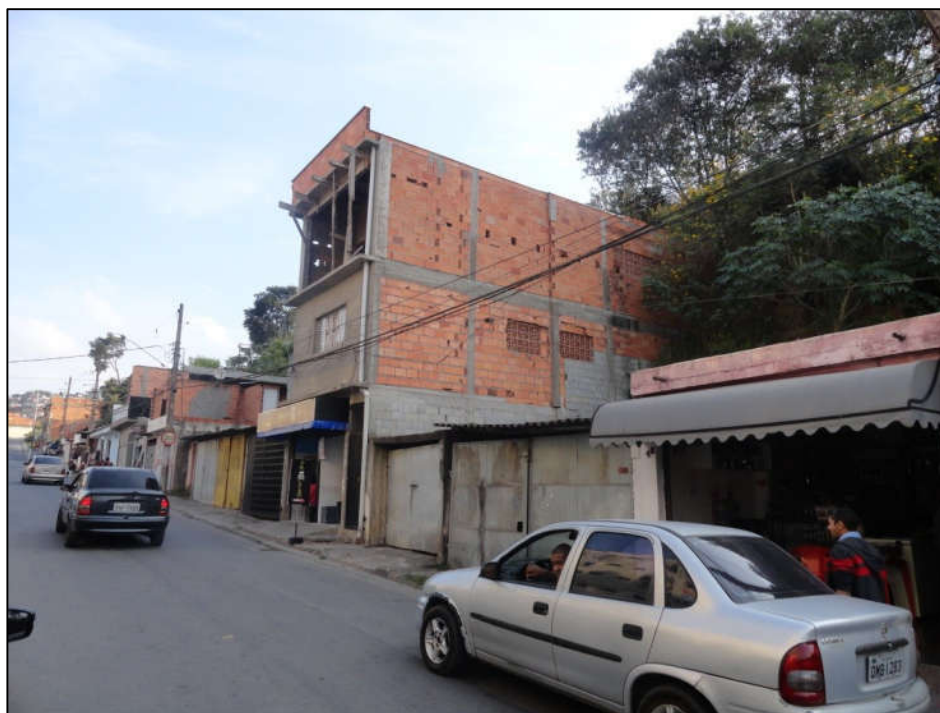
Foto FC-ITA-05-01.02: Vista da ocupação em alvenaria na base do talude natural e do talude de corte, em frente à Rua Japi.
