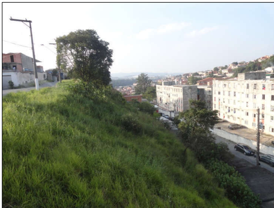
Foto FC-ITA-05-01.01: Vista do talude de encosta natural a partir da Rua Macachas.
