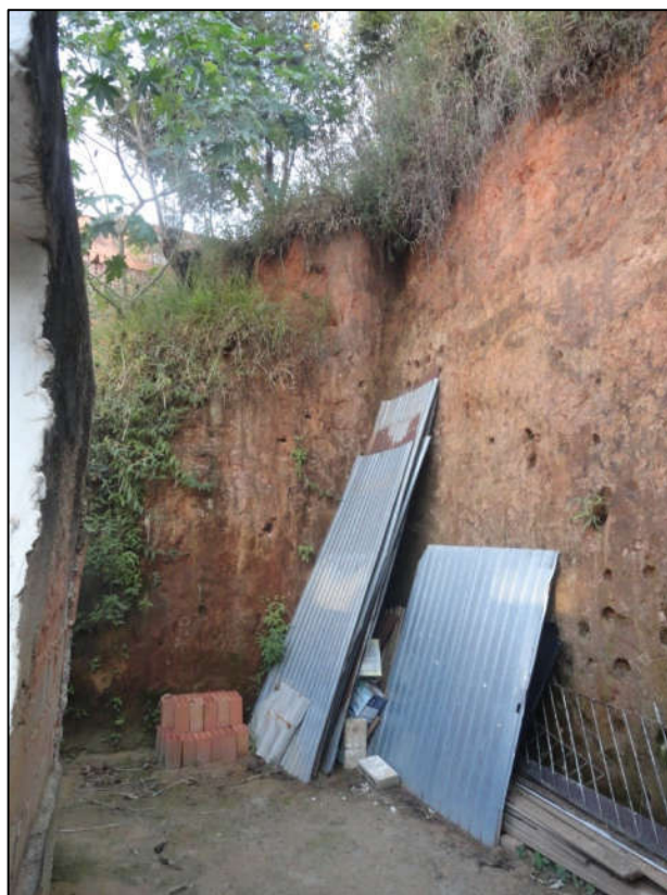
Foto FC-ITA-05-02.04: Detalhe do mesmo talude da foto anterior.
