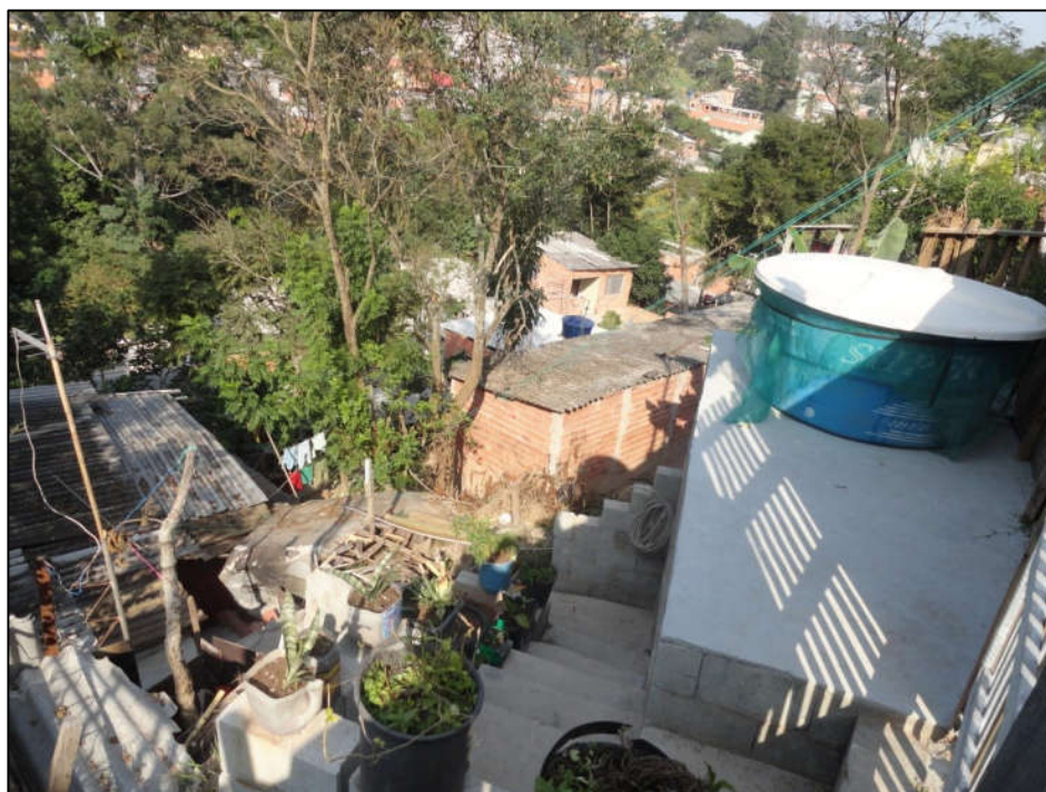
Foto FC-ITA-05-05.04: Vista do trecho central do setor com moradias em alvenaria.
