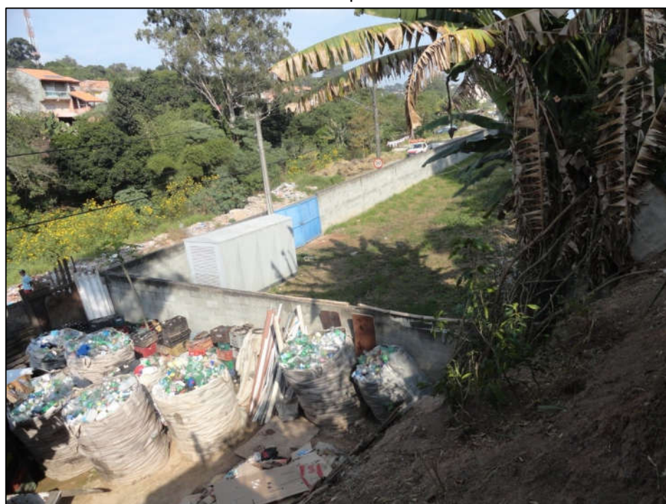
Foto FC-ITA-05-05.02: Trecho do setor com propriedade da Sabesp e depósito de material para reciclagem, ambos em frente à Rua Japi.
