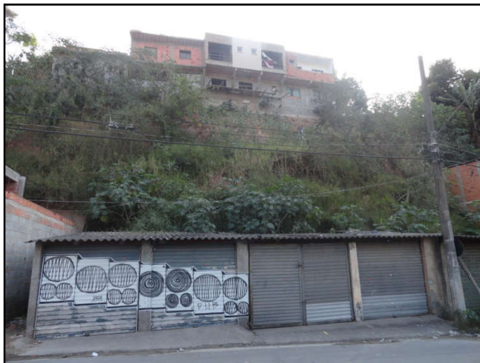
Foto FC-ITA-05-03.01: Vista frontal do setor com as 03 moradias no topo, a cicatriz do escorregamento e as 06 garagens na base, em frente à Rua Japi.
