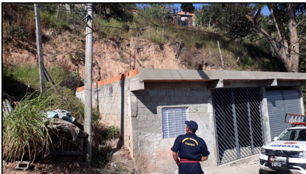
Foto FC-ITA-07-02.01: Vista geral do setor.
