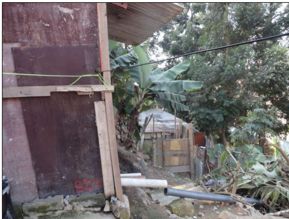
Foto FC-ITA-05-06.04: Lançamento de águas servidas diretamente sobre os taludes de corte.
