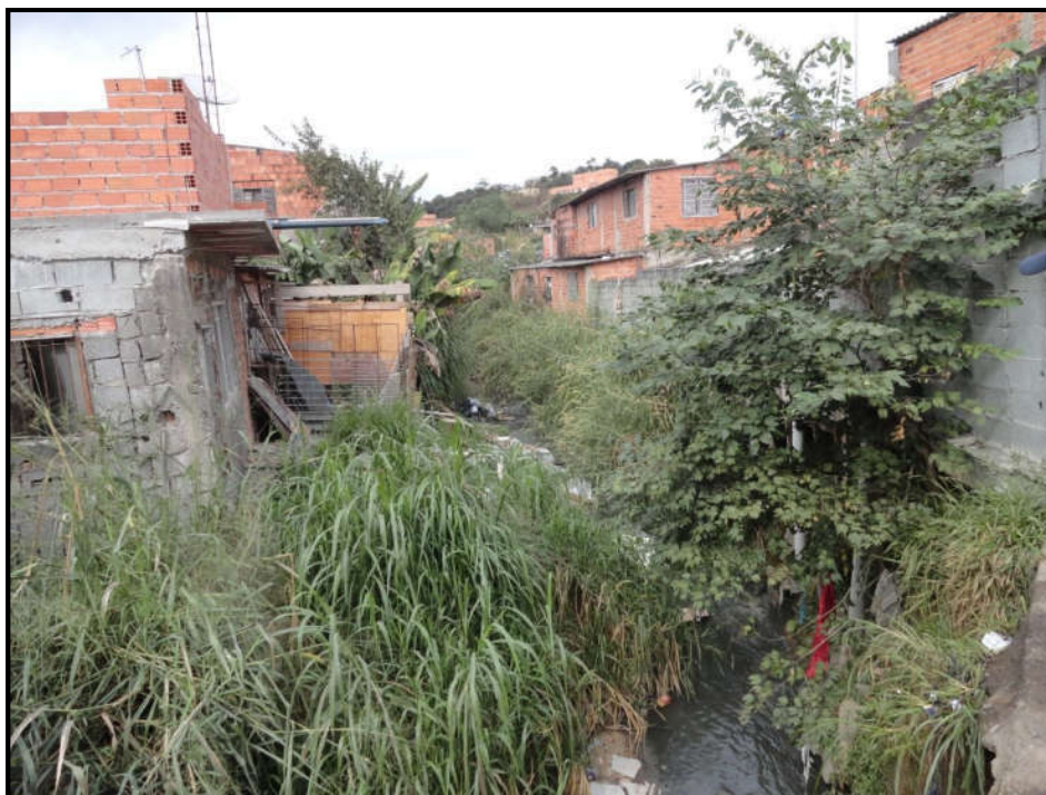
Foto FC-ITA-06-01.01: Vista do talude marginal e das moradias situadas no topo.
