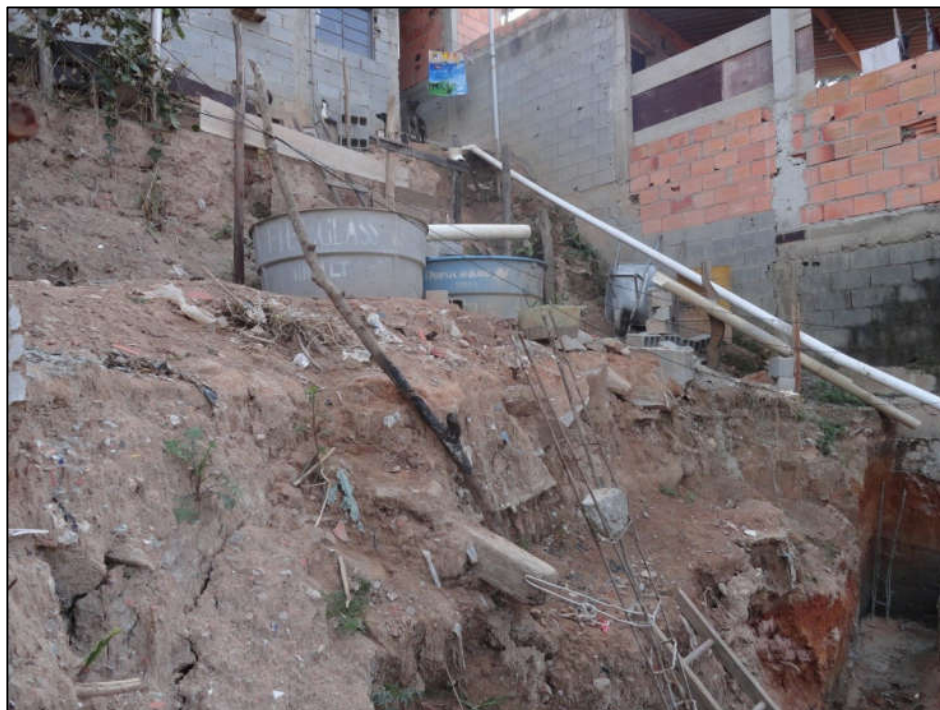
Foto FC-ITA-05-04.03: Situação no trecho central do setor com corte em aterro lançado.
