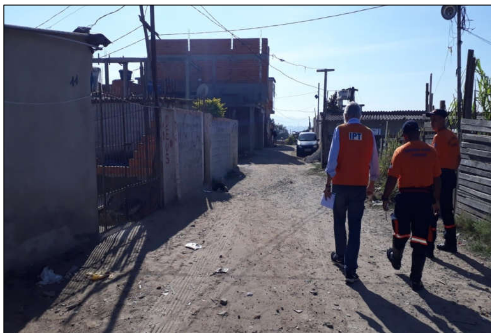
Foto FC-ITA-07-03.04: Vista das moradias situadas na rua Milton José Cezar Rezende.
