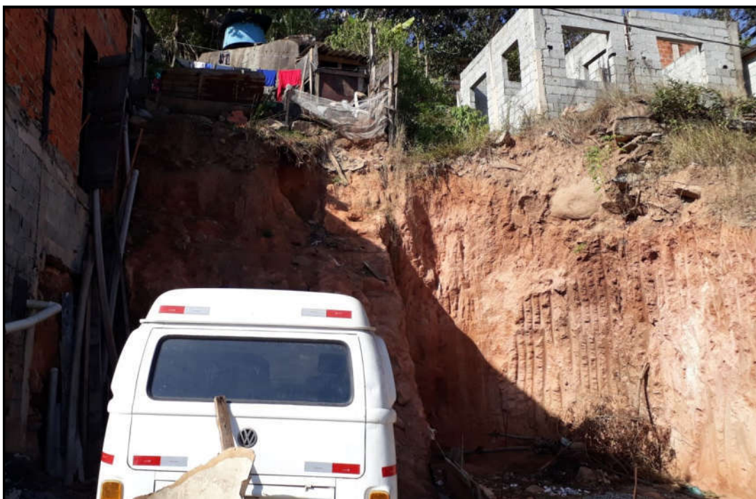
Foto FC-ITA-07-01.01: Vista geral do talude de corte.
