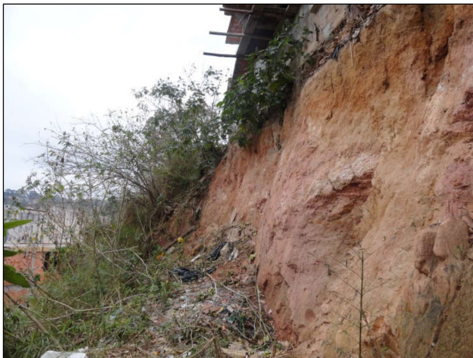
Foto FC-ITA-05-03.05: Outra vista do talude vertical da cicatriz do escorregamento com aproximadamente 7 m de altura.
